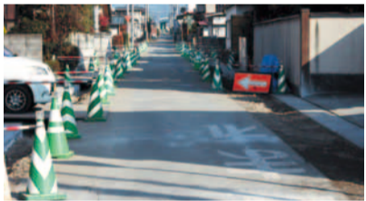
▲北久野本町内の道路拡幅工事
