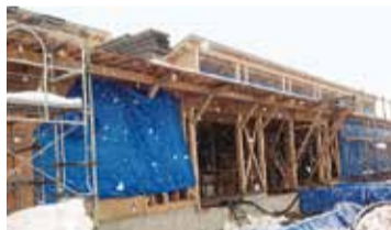
村山特別支援学校の増築工事
