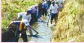
水路の泥上げ
