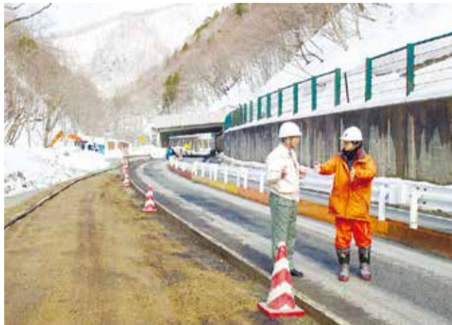
▲スノーシェッド工事中の国道48号線 (ことし1月)
