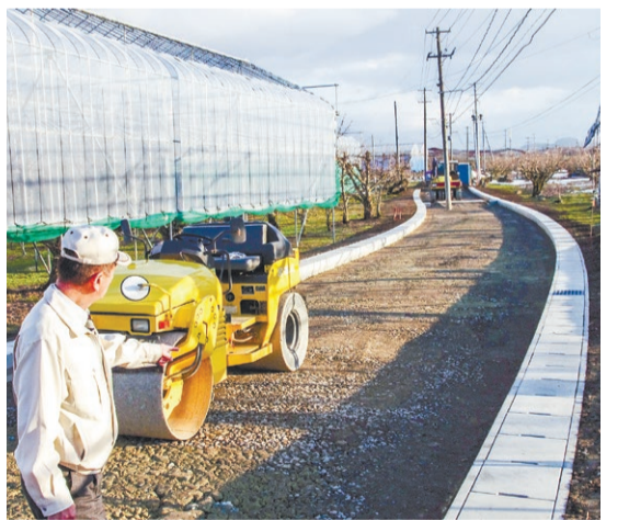
工事中の天童市道向原1号線
