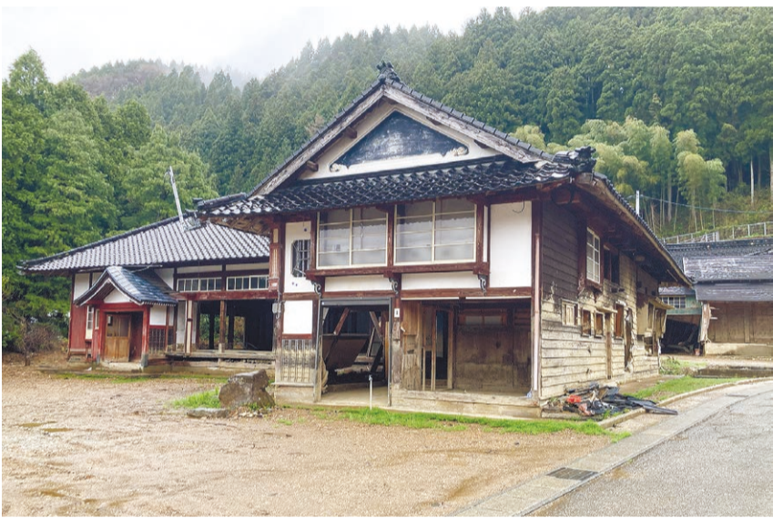
国の公費解体の対象となった被災家屋
